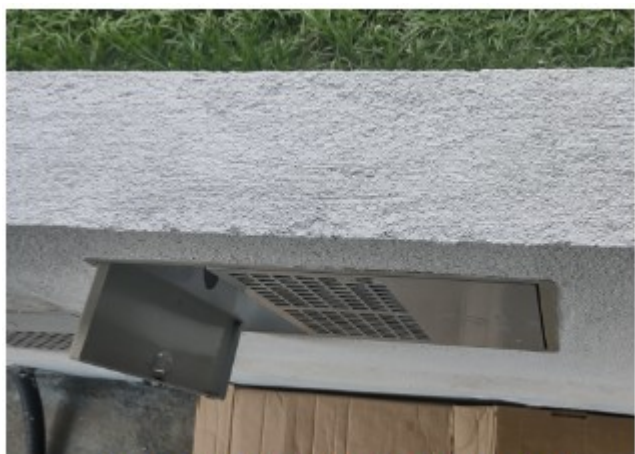
Imagem 5: vista superior de uma mureta (1)
