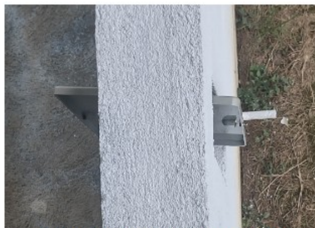
Imagem 6: vista superior de uma mureta (2)
