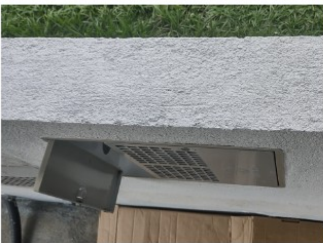
Imagem 5: vista superior de uma mureta (1)
